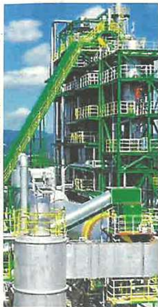
日田市天瀬町の木質バイオマス発電所
